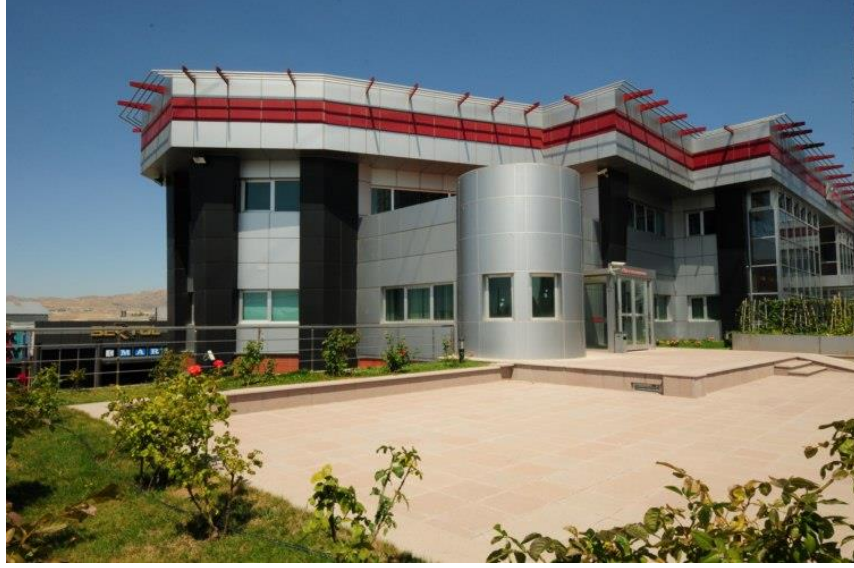
Şekil 6.4. Ankara OSTİM idare binasının görünümü
