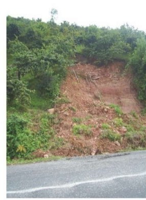
Foto:14 Yol kenarlarında oluşan küçük heyelanlar.
